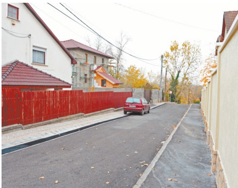
Evezős utca: csapadékelvezető-rendszerrel kiépített járda
